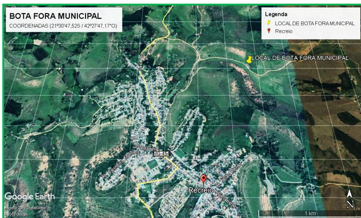
Figura 17 – Localização do Bota Fora Municipal. Fonte: Google Earth – Adaptação Ideal Consultoria Ambiental e Urbanística LTDA.
