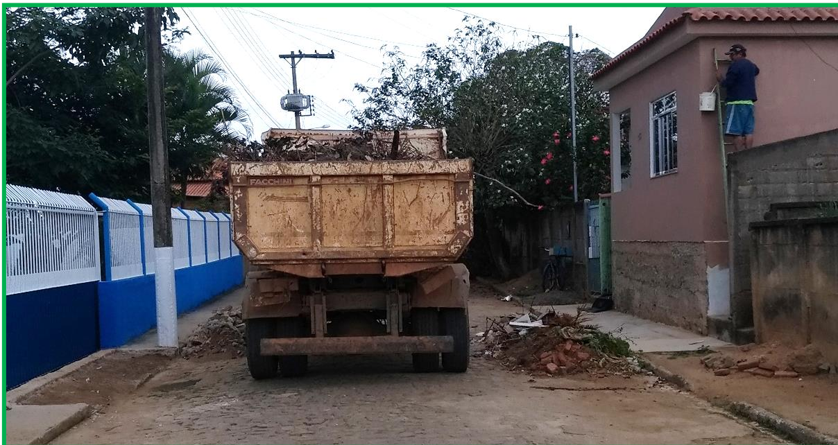
Figura 43 – Coleta de resíduos provenientes de construção civil. Fonte: Ideal Consultoria Ambiental e Urbanística LTDA
