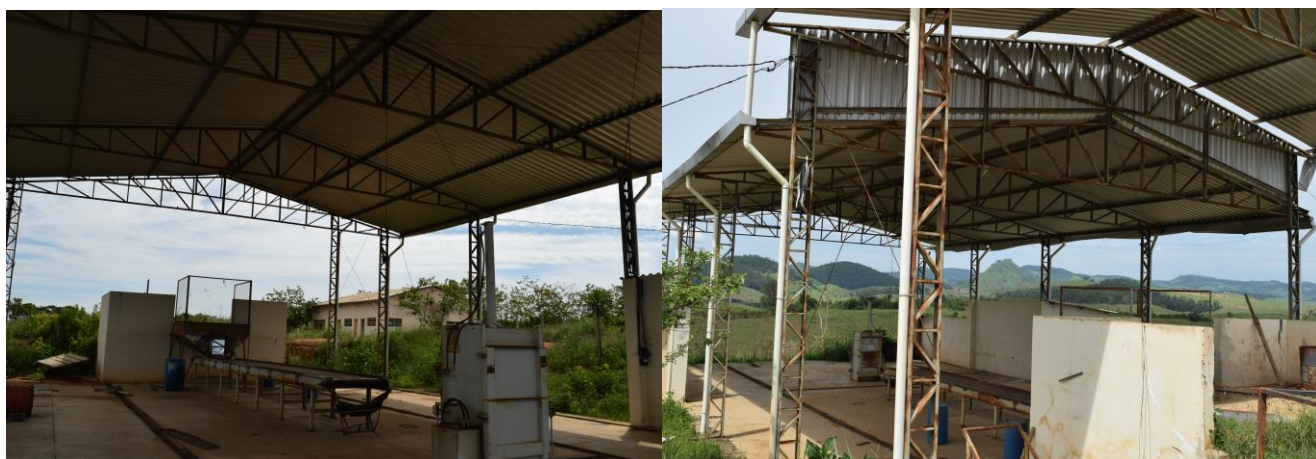
Figura 18 – Usina de Triagem e Compostagem de Resíduos Sólidos Fonte: Secretaria Municipal de Desenvolvimento Urbano.
