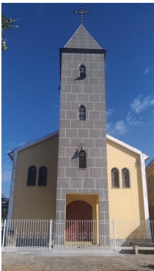
Figura 12 - Igreja de São Joaquim e Santana no distrito de Angaturama.
