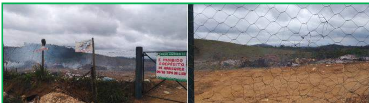
Figura 43 – Local de bota-fora do lixo de construção civil e limpeza urbana.
