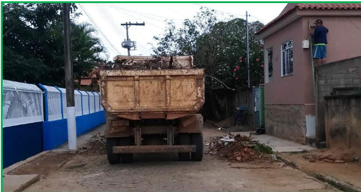
Figura 54 – Coleta de resíduos provenientes de construção civil. Fonte: Ideal Consultoria Ambiental e Urbanística LTDA
