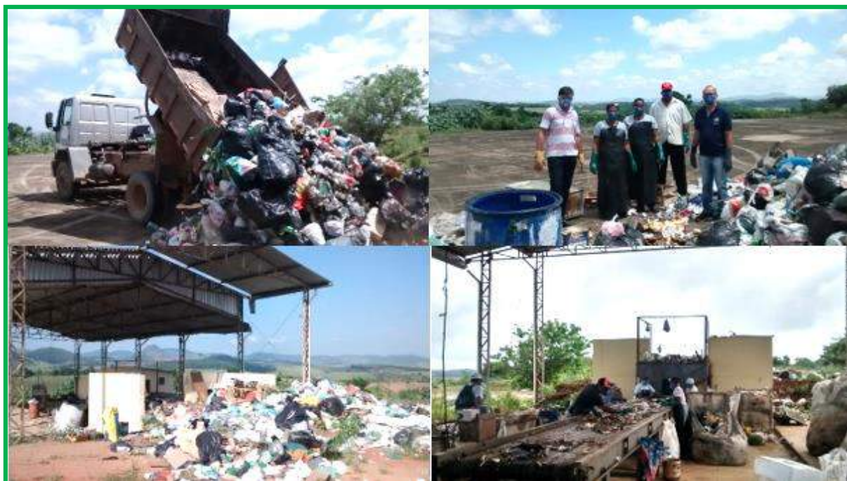
Figura 22 – Etapas do processo de gravimetria – Local “UT” – Usina de Triagem de Recreio/MG – Distrito de Conceição da Boa Vista.
