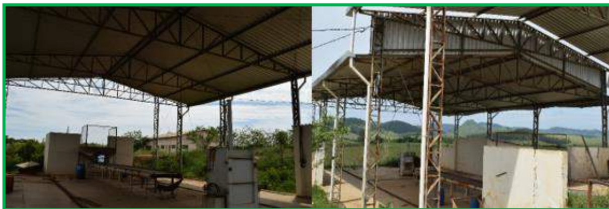
Figura 12 – Usina de Triagem – UT no Distrito de Conceição da Boa Vista. Fonte: Ideal Consultoria Ambiental e Urbanística LTDA.
